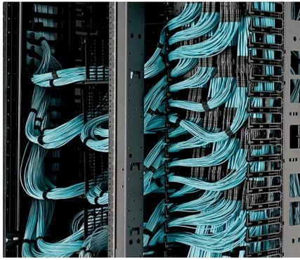
**Kabelführung** – Innovative Kabelführung unterscheidet das HD Flex™-System von seinen Mitbewerbern. Die hintere Stammkabelverwaltung und -platte bietet eine Plattform zur Montage von Kabeln, und seitliche Kabelführungen leiten die Kabel weg von der Rückseite des Gehäuses und sorgen für einfacheren Zugang zu wichtigen Anschlüssen.
